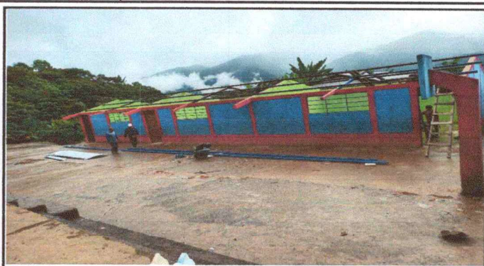
Foto 2: Proceso de destechado de láminas de zinc oxidados y sustitución de costaneras en el módulo 2.
