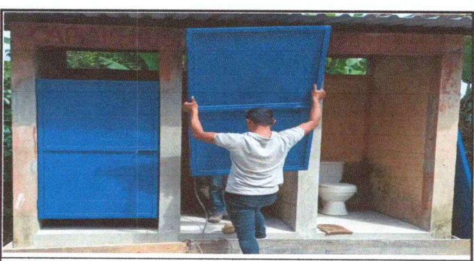
Foto 6: Remozamiento en el área de baño con colocacion de puertas de metal.
