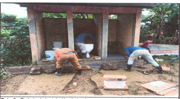
Foto 5: Trabajo de instalación de inodoros y remozamiento de piso en el área de baños.
